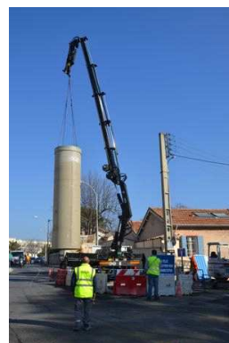
Tronçon de la conduite verticale destinée à la poursuite des travaux
