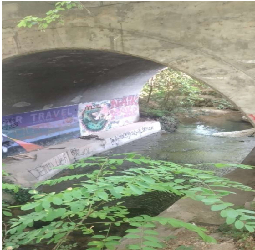
Tunnel sous le cours Gambetta
