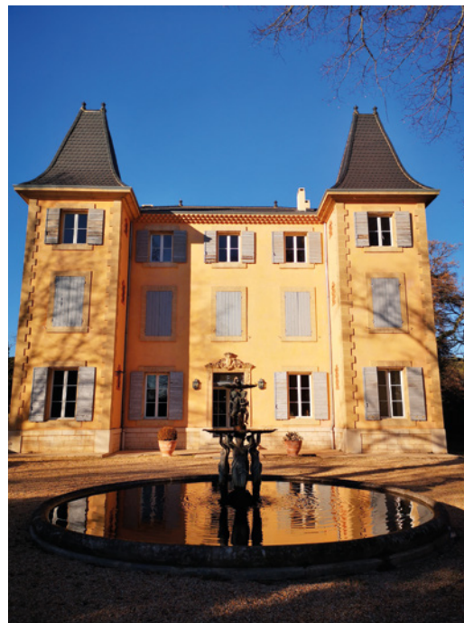
Façade sud, bassin, Château de la Brillane
