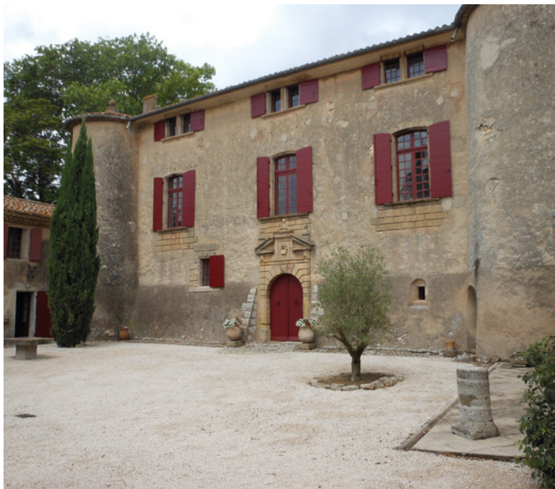
Façade aux deux tours, portail Renaissance, Château de la Calade
