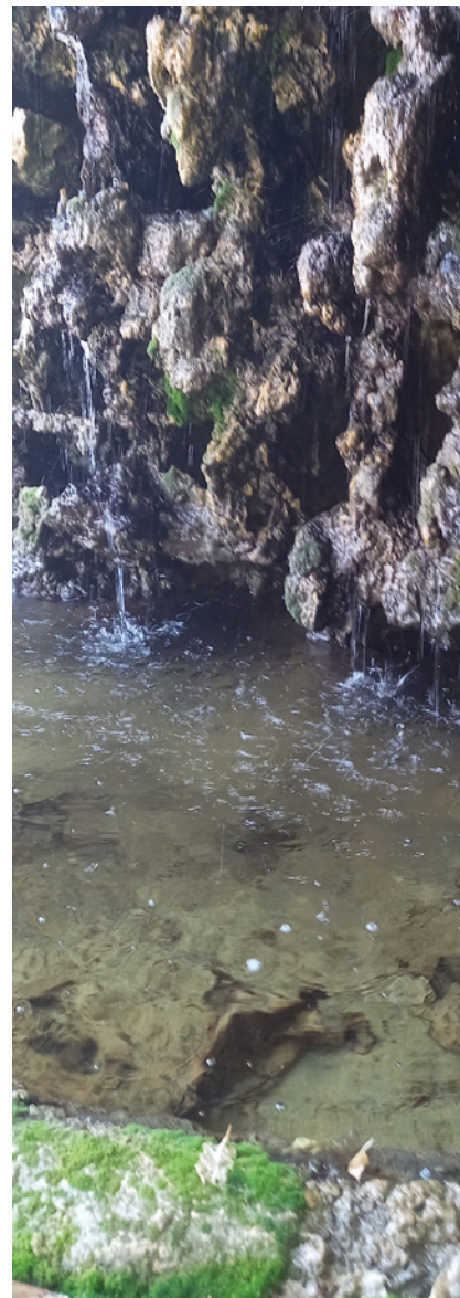
Eaux ruisselantes, Château d'Alphéran
